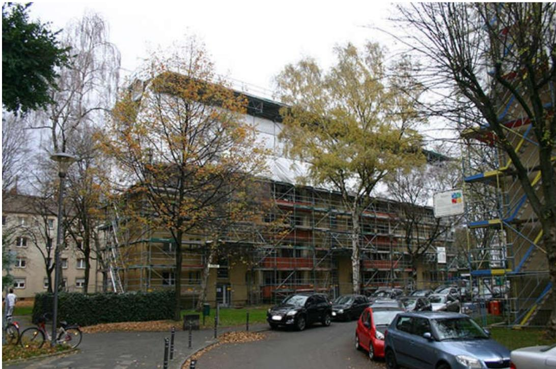
**Bild 4** Haus wird um Balkon, Fahrstuhl und ein Obergeschoss erweitert (Quelle: DEWOG 2018)
